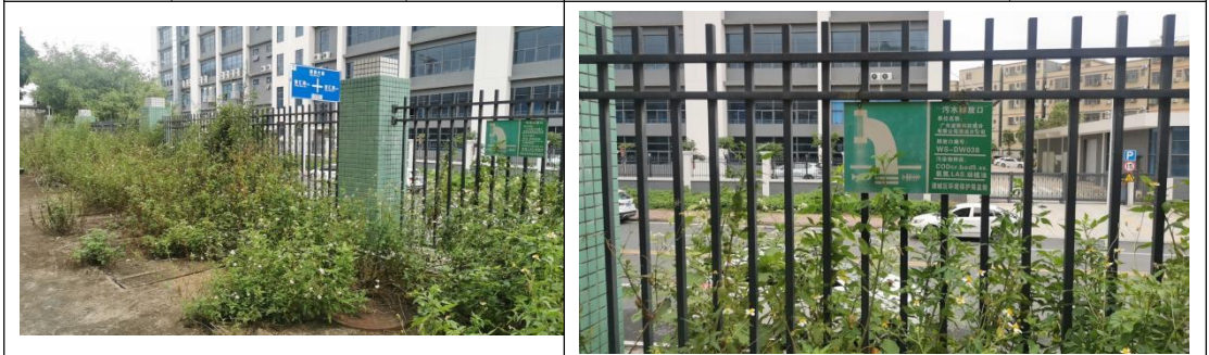
废水处理设施 图 1
