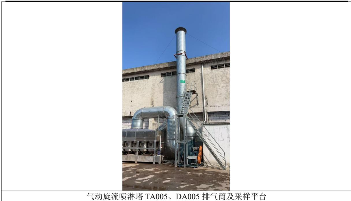
气动旋流喷淋塔 TA005、DA005 排气筒及采样平台
