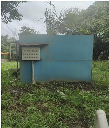
清远市昌盛铜材有限公司已配置的三级化粪池+一体化生活污水处理装置
