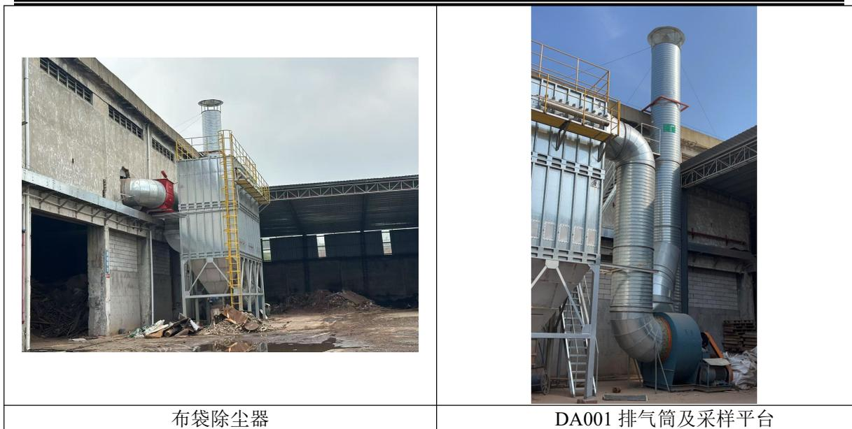
图 8 卸料、给料工序收集设施、废气处理设施、排气筒实景图
